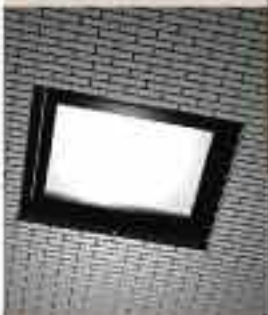
VISTA DESDE EL EXTERIOR
