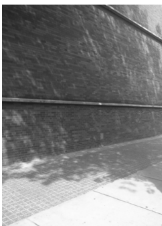
Fig. 9 Detalle de la entrada del muro sur de la Galería Fig. 10 Detalle del muro de ladrillo.
